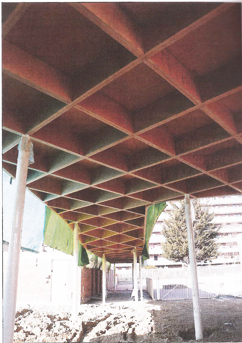
Gewagt: Boris Schneider und Jean-Luc Sandoz nutzten Pollmeiers Baubuche, um ein Deckengewölbe bis in den Schulhof fortzusetzen. Fotos: J. Tophoven
